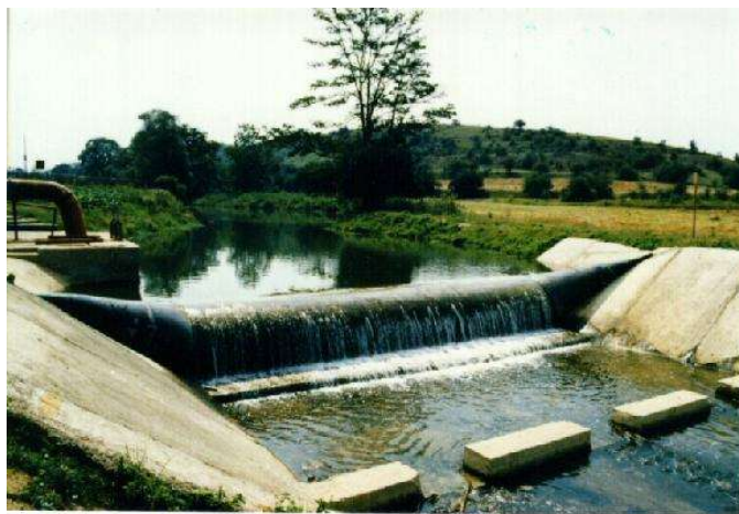
Фиг.2.2. Стационарна мембранна хидротехническа конструкция на р. Макоцевска
